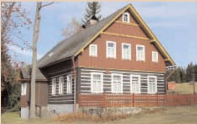
Stavení s vaznicovým krovem v Karlově
